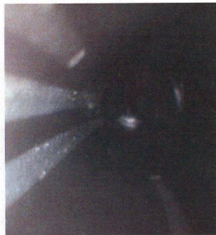
排水管高圧洗浄後(ビデオスコープ使用)
